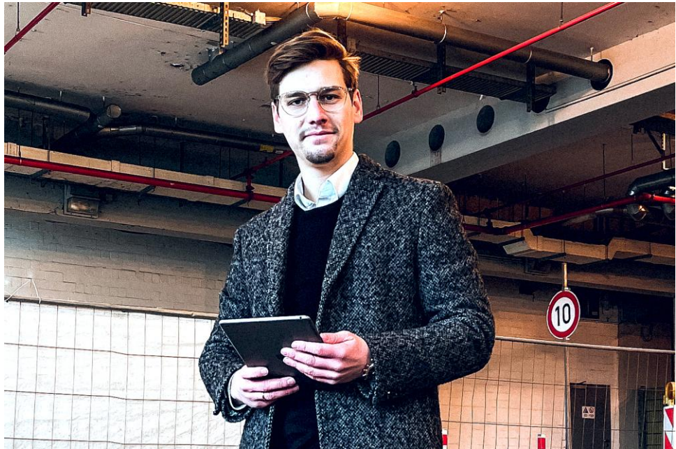
Das Tablet als Standardausrüstung auf der Baustelle: RIF-Mitarbeiter David Jung unterwegs im RIF-Projekt MobiDik, Ziel ist eine neue Technologieplattform für effizientere, smartere Baustellen.
